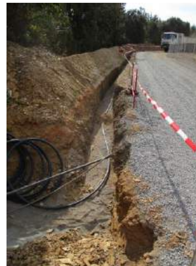
Figure 266 : Exemple de tranchée en bordure de piste – Q ENERGY France
