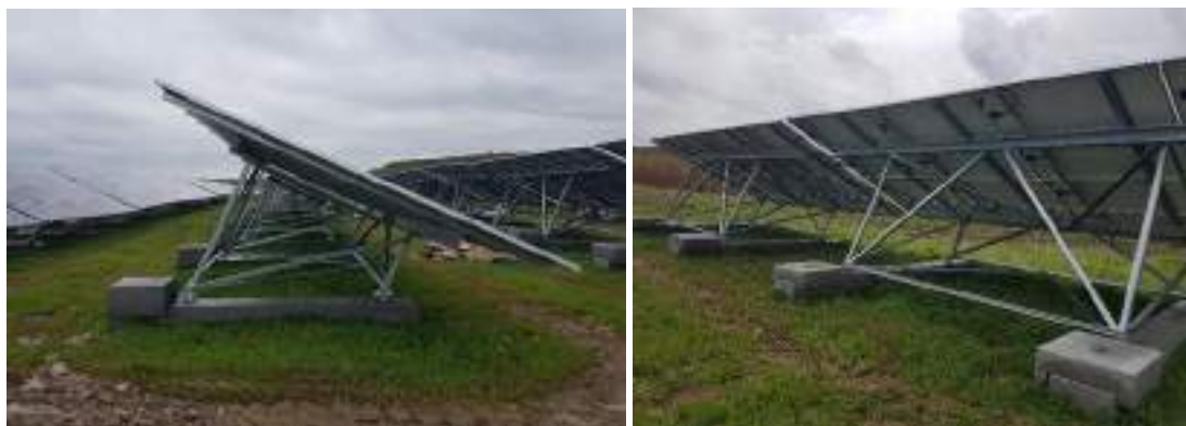
Figure 254 : Exemple de fondations béton – Q ENERGY France
