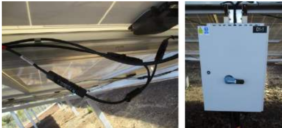
Figure 259 : Exemple de câble électrique et de boîte de raccordement (source : Q ENERGY France)
