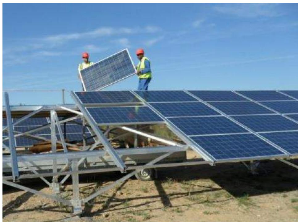
Figure 265 : Exemple de mise en place des panneaux sur les structures – Q ENERGY France
