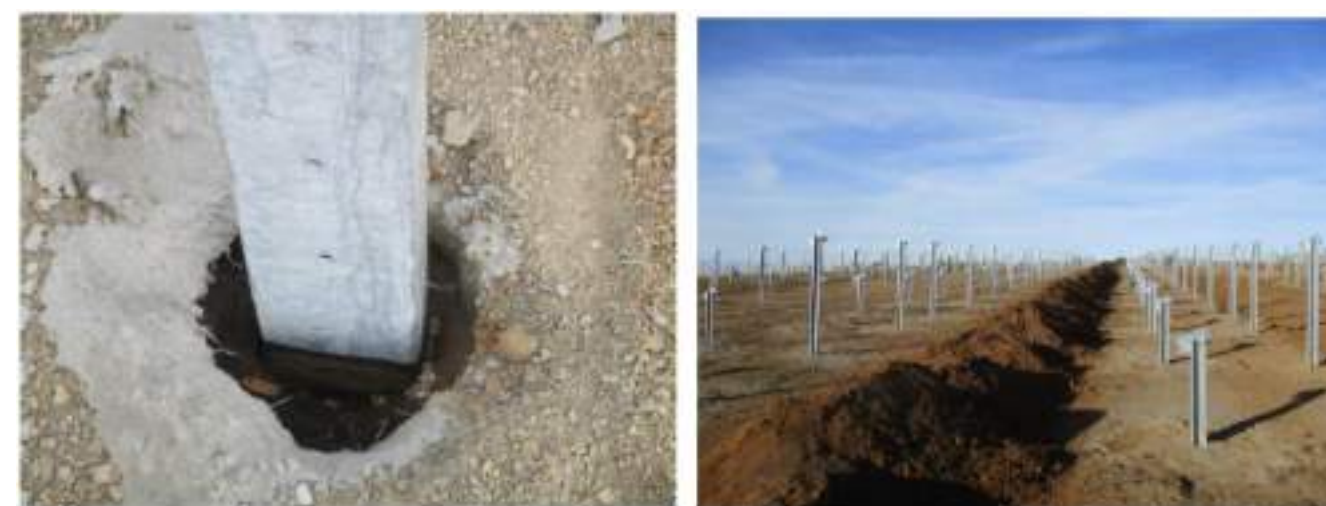
Figure 252 : Exemple de fondation type pieux – Q ENERGY
