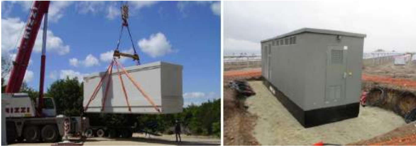
Figure 267 : Installation d'un poste électrique
